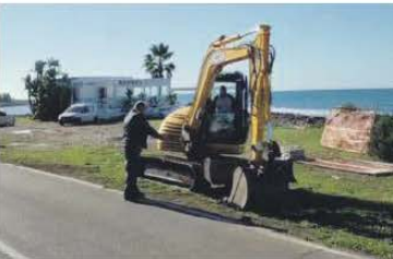
CANTIERE di movimentazione terra a Valeriano
